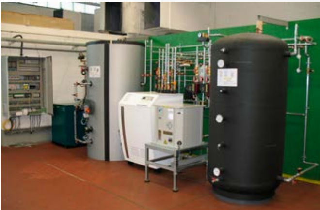
Bild 1: Ansicht des \mu KWKK-Labors (von links nach rechts: Schaltschrank mit Anbindung an das elektrische Microgrid, Blockheizkraftwerk, Wärmespeicher, reversible Adsorptions- und Kompressionskältemaschine und Kältespeicher) mit Messdatenerfassung und Klimakammer (hier mit Prozessthermostaten, rechts).
